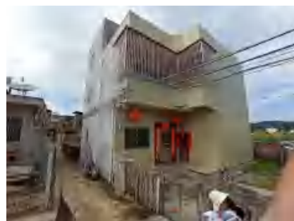
电力电信线缆
